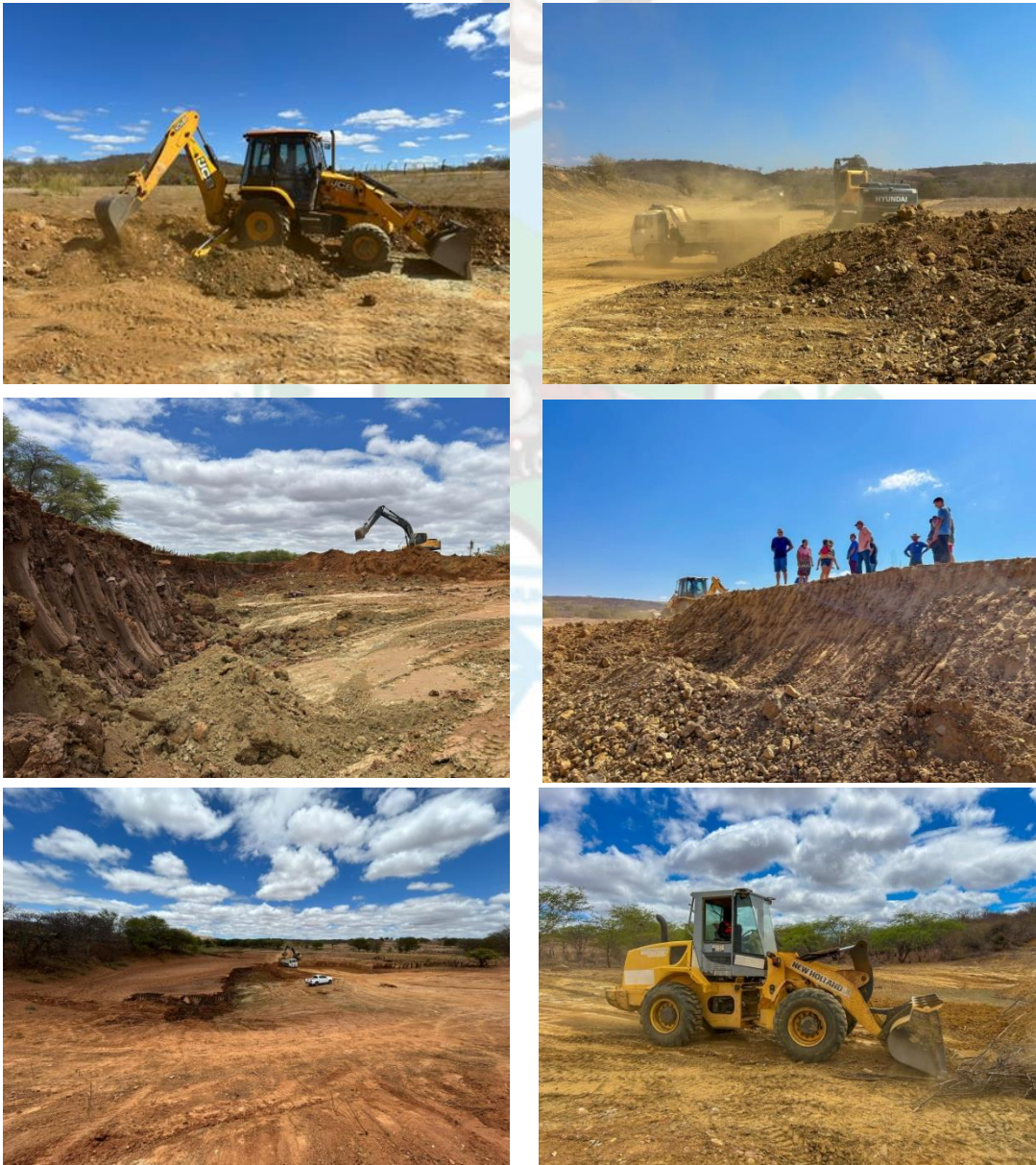
Figura 100: Recuperação de Barragens
